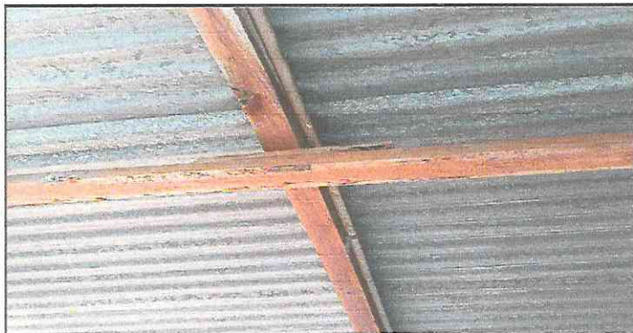
Foto 5: Sustitucion de madera por metal
