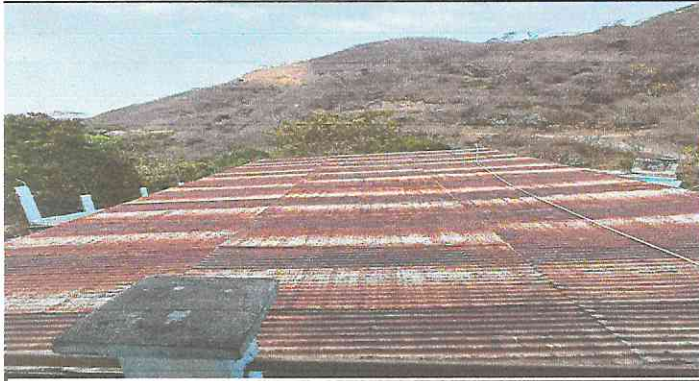
Foto1: sustitución de lamina por lamina calibre 28
